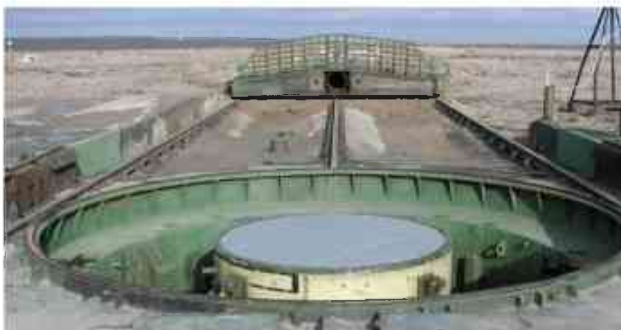
Рисунок 2 – Транспортно-пусковой контейнер с противоракетой системы ПРО А-135 в шахтной пусковой установке
